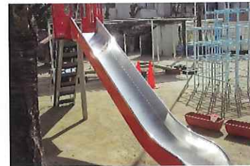
園庭遊具の設置 (令和2年度 京都府長岡京市)
